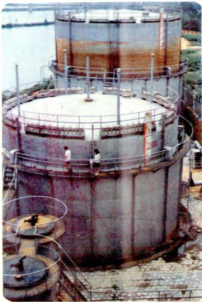
二电厂煤气站
