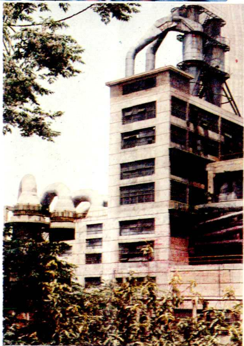
二电厂煤仓间
