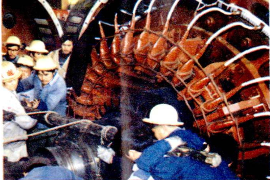
二电厂一号机组检修
