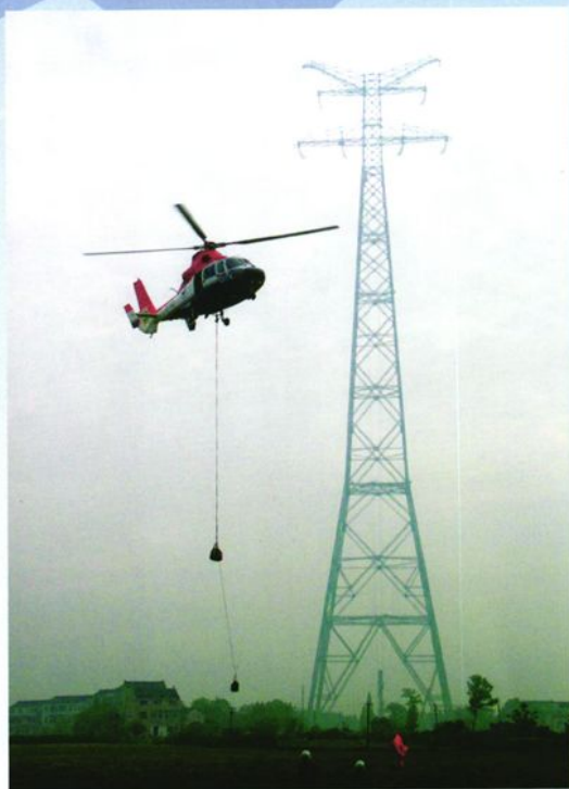
500千伏输电线路江阴大跨越施工，用直升机拉线(2002年摄)
