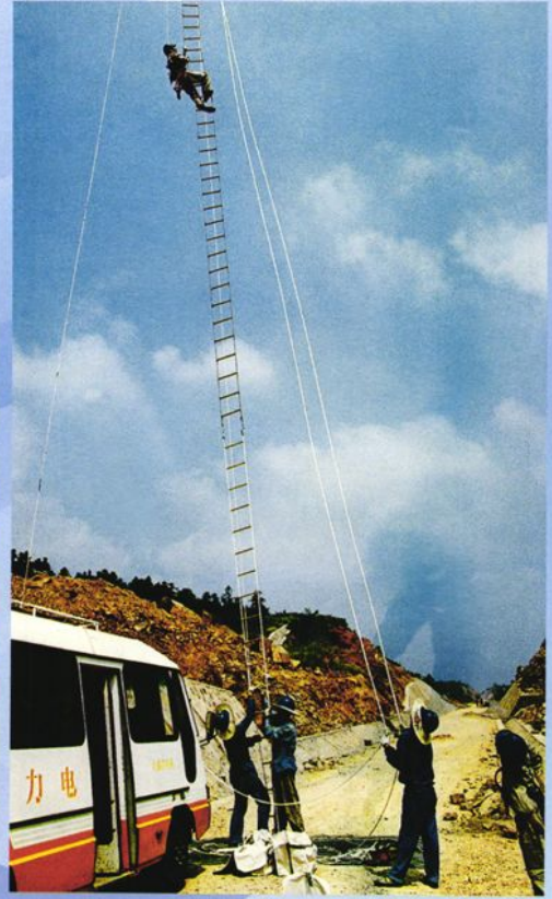
500千伏带电作业
