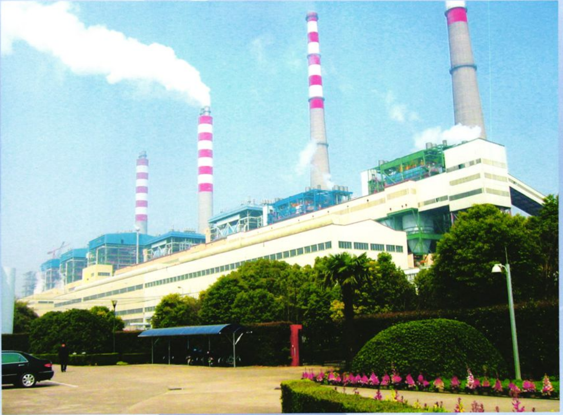
江苏利港电力有限公司(2002年摄)
