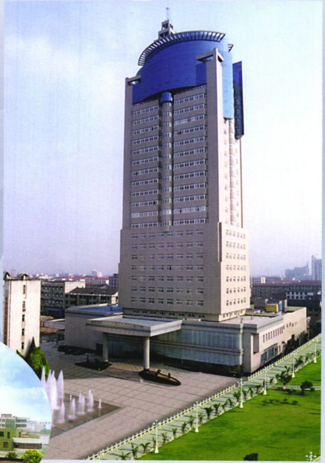
江阴市供电局电力调度大楼 (1999年摄)
