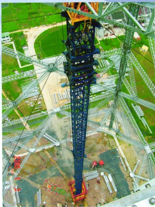
500千伏输电线路江阴大跨越铁塔(366米)在建设中
