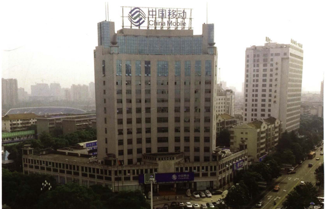
常德市移动分公司办公大楼，座落在常德市武陵大道中路。
