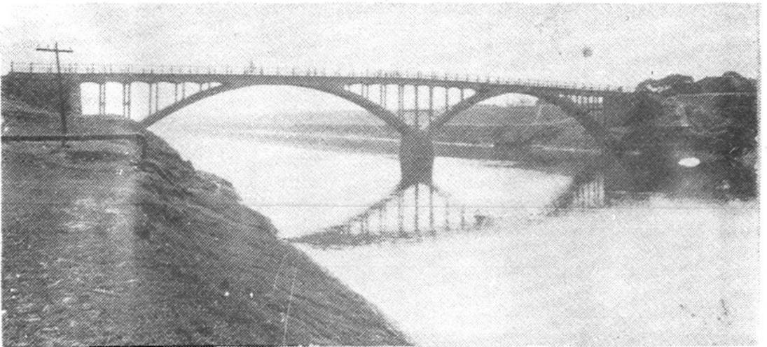
罗溪南阳公路桥
