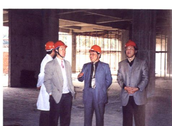
2003年3月，武进区卫生局局长金建清（右一）、副局长朱学云（左二）视察医院住院大楼建设工地。
