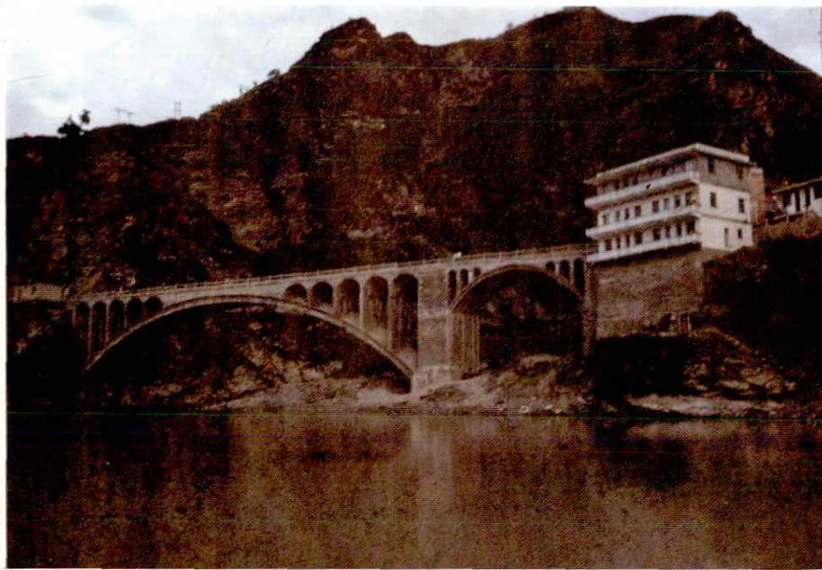
旬(阳)白(河)公路冷 水河大桥
