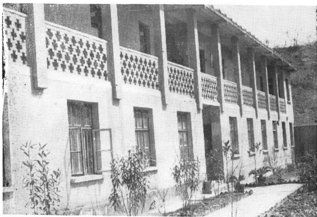
修建处办公楼（1971年建成）
