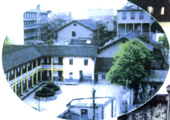
南充县人民医院全貌
