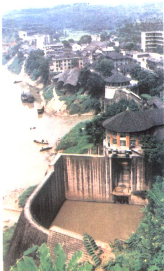
南充县青居水电站外貌
