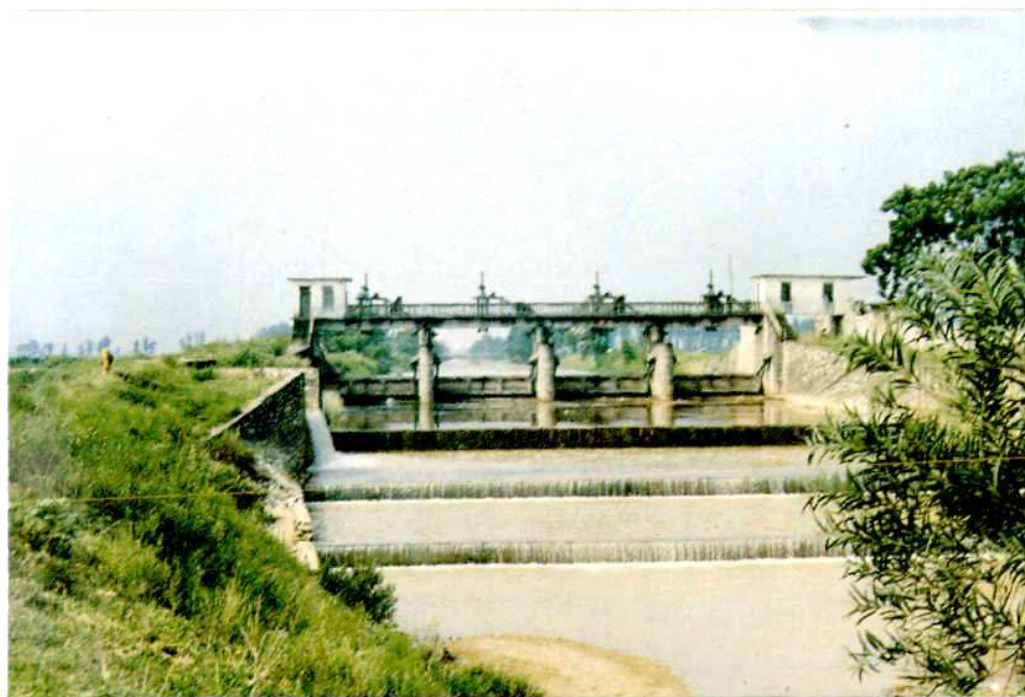
△ 大新镇白沙江大泉渠水闸
