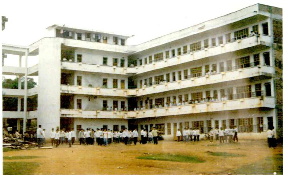
△大新镇第二初级中学教学楼
