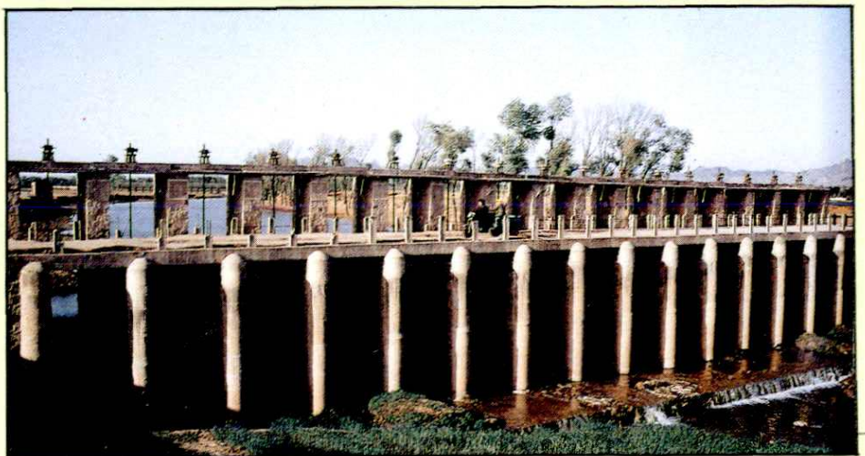
21 梁深港拦河闸
