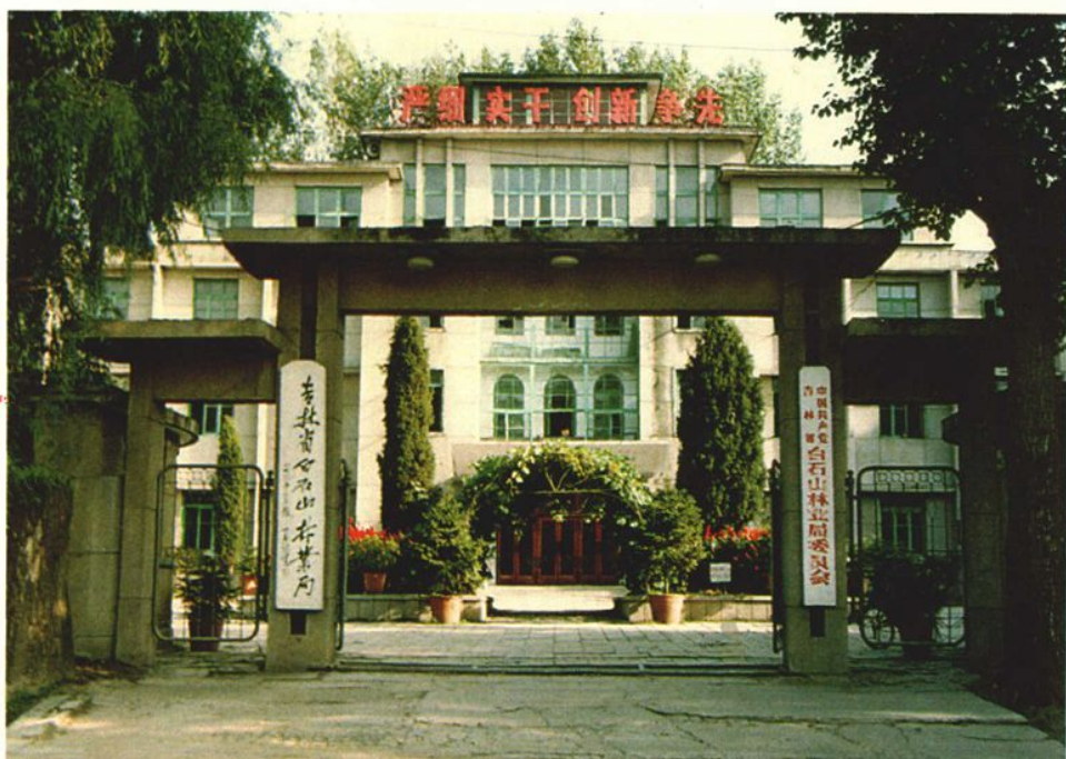
白石山林业局机关办公大楼
