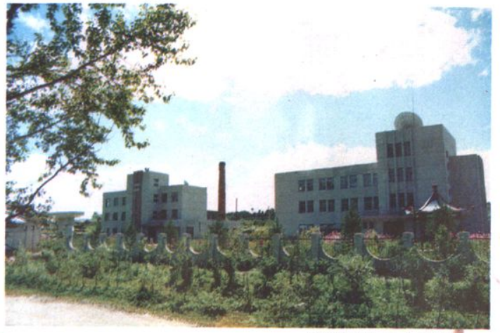
胜利河林场办公楼
