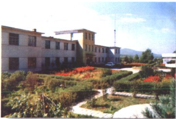
双山林场办公楼
