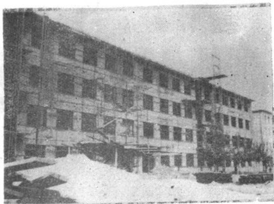
即将竣工的实验楼 图3
