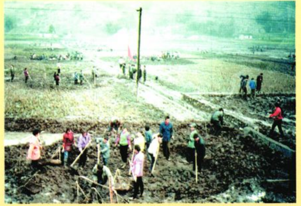
实施稻鱼田工程工地热火朝天
