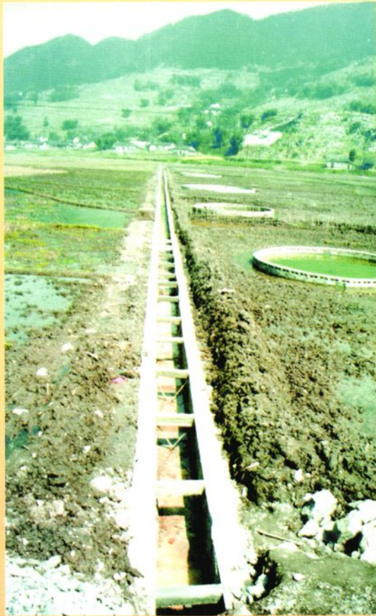
久庆镇下湿田改造工程
