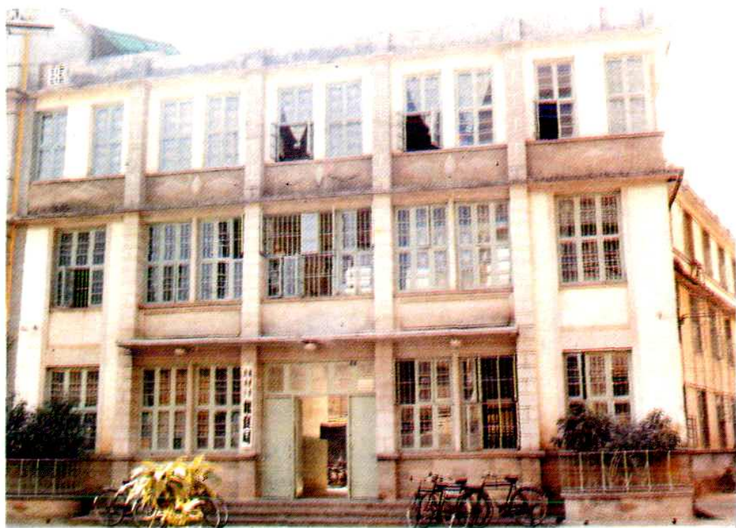
南靖县粮食局办公大楼
