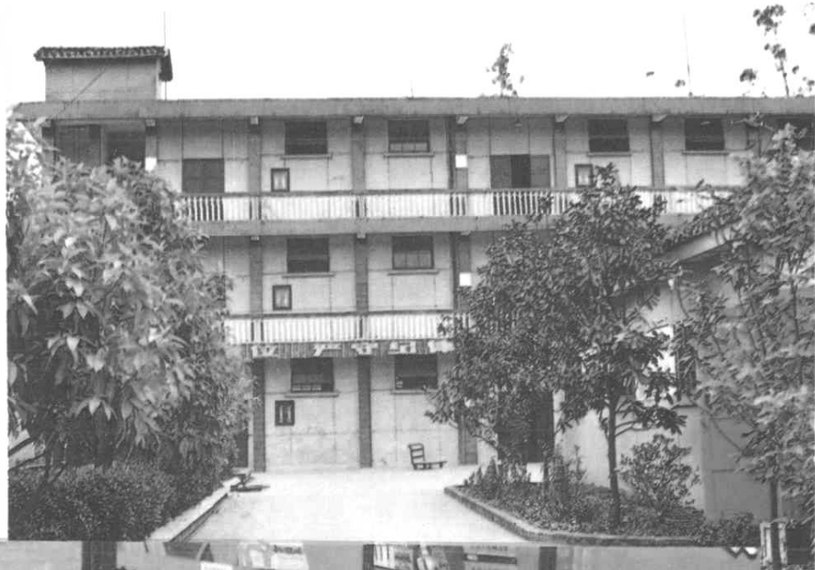
► 自贡市医药公司化试仓库
