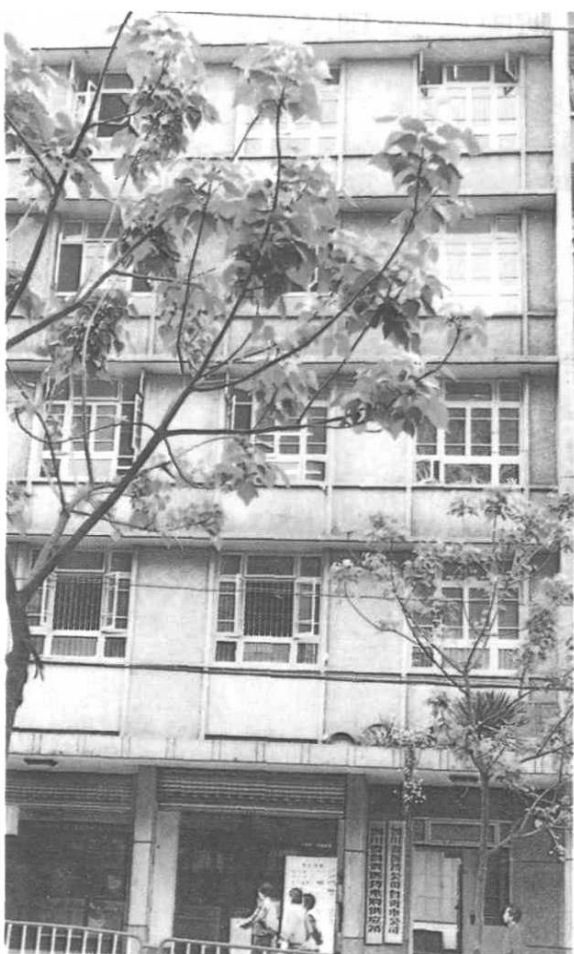
▲ 自贡市医药公司办公大楼
