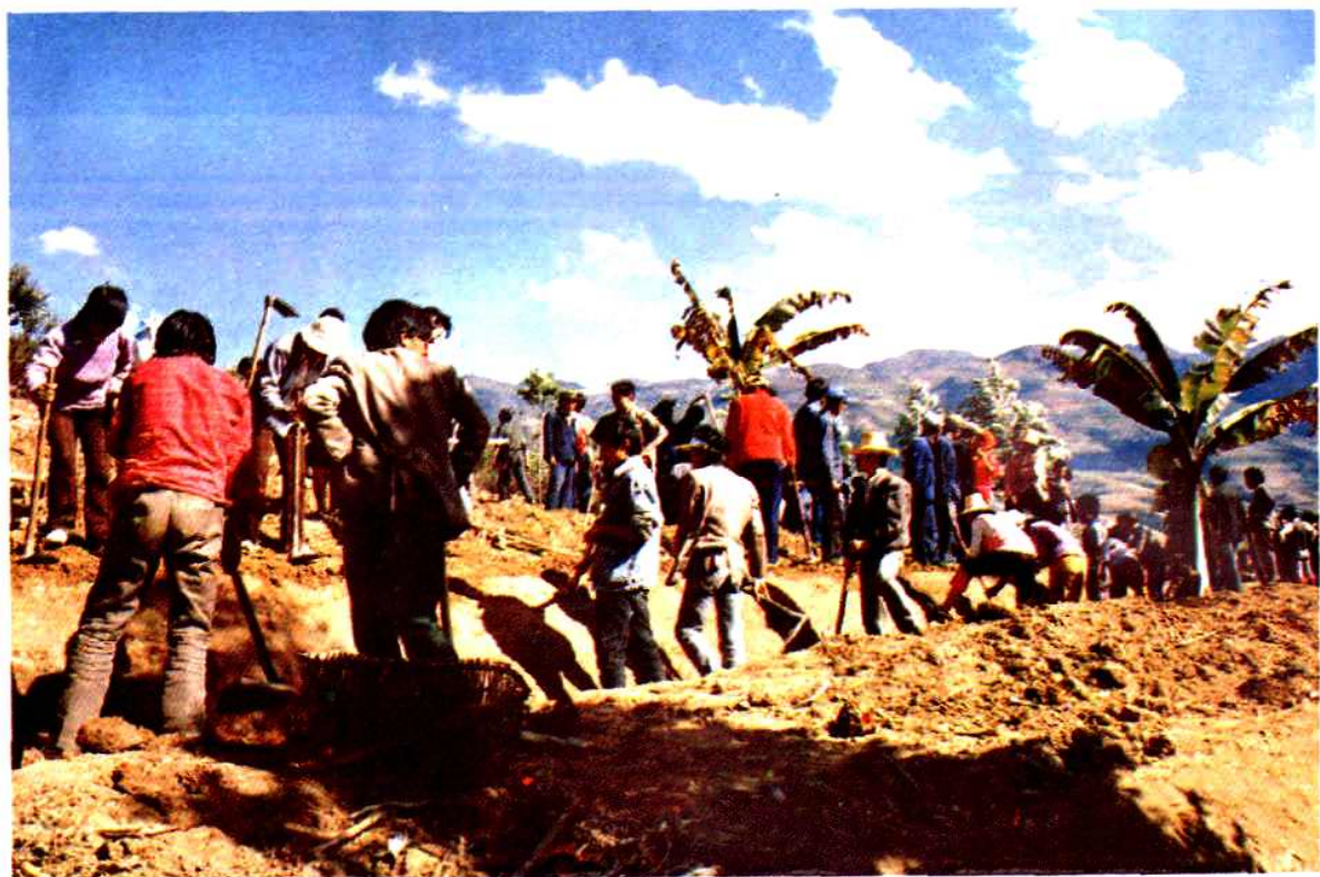
▲坡改梯场面一角
