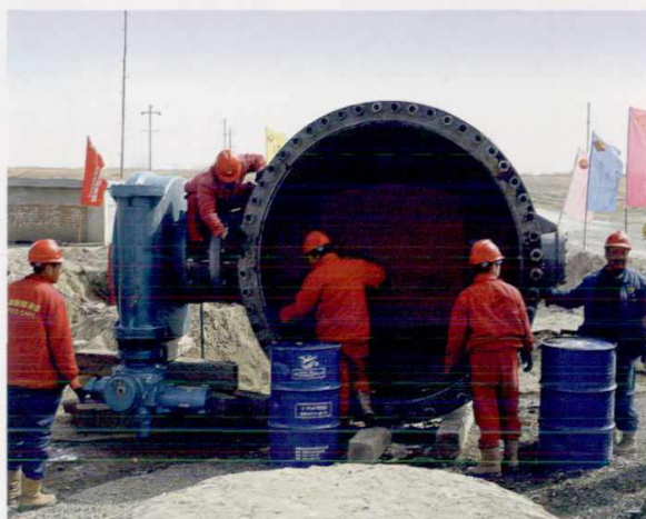
农业综合开发区规划的一期27万亩土地开发输水管网工程全部采用钢管、玻璃钢管、PVC管，采取密闭的地下管道保压密封输水方式，建成管网相连，农管出水口至地头进行喷、滴灌的节水灌溉系统。从西郊水库出水口经主干管14.6千米，再向东、西、南方向分支供水。供水支管线上每隔400米的井池内设置控制阀、排气阀和压力表等。
