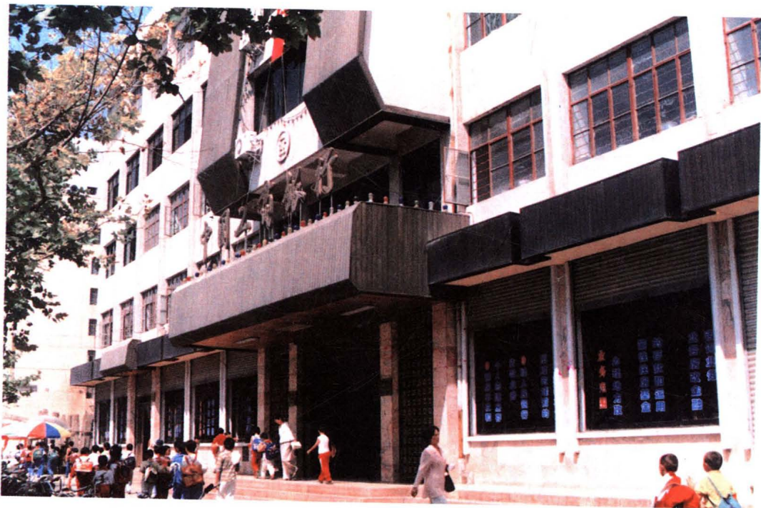
▲ 中国工商银行天水市分行办公楼
