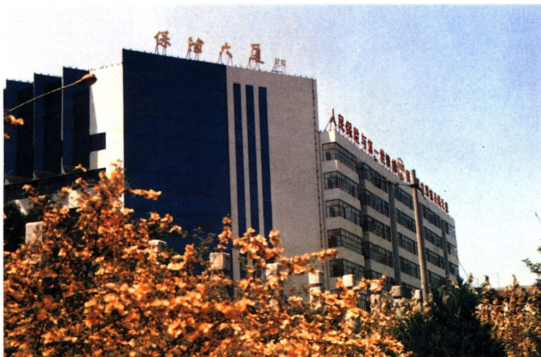
▲ 中国人民保险公司天水分公司大厦外景
