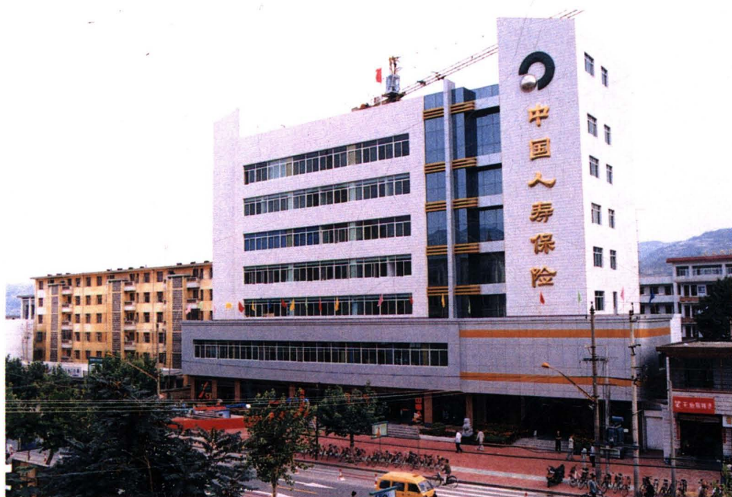
▲ 中国人寿保险公司天水分公司办公大楼
