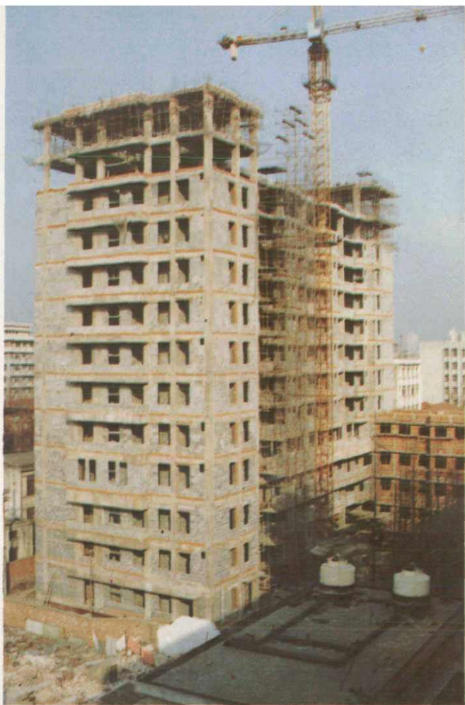
建设中的外科大楼
