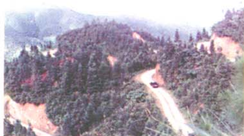
▲民族地区乡乡通公路。 图为蓝山汇源瑶族乡公路。
