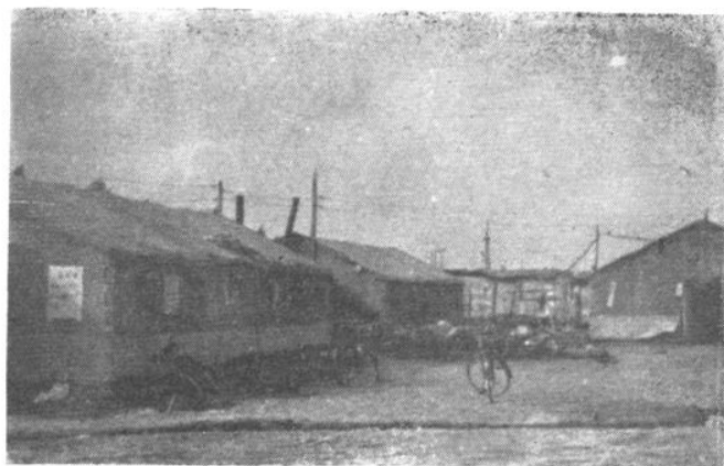
一九七五年建厂初期的机关住址
