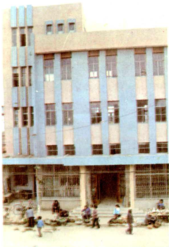
水北供销社营业大楼一侧
