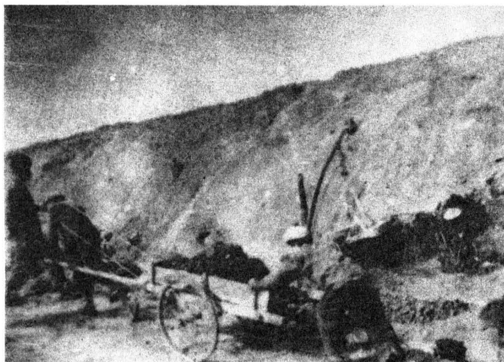
架梁开始 前，工人们给 桥头线路作加 固工作。
