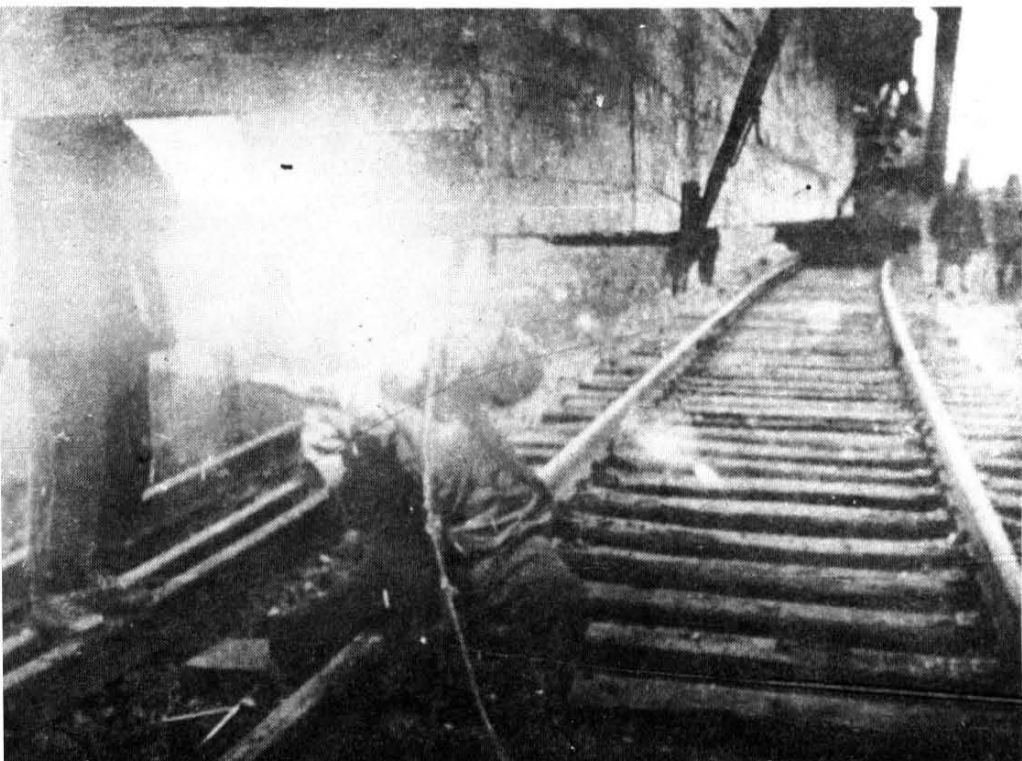
电焊工人 忙着焊接 螺栓，给桥 靴钉上“靴 带”。
