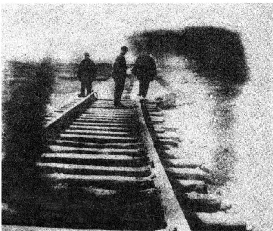
吴幼怀工 程师、张长富 队长、金丰海 安全技术员检 查用 24m 铨 梁拨道方法架 设的线路情 况。
