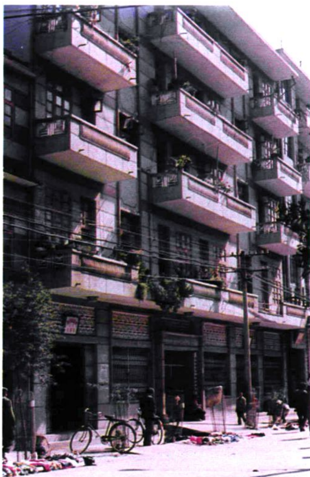
富宁县医药管理局(公司)综合楼
