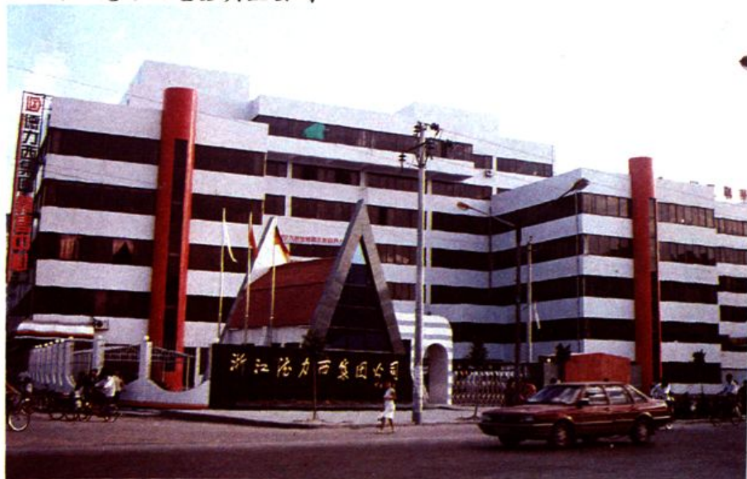
13. 浙江德力西电器实业公司
