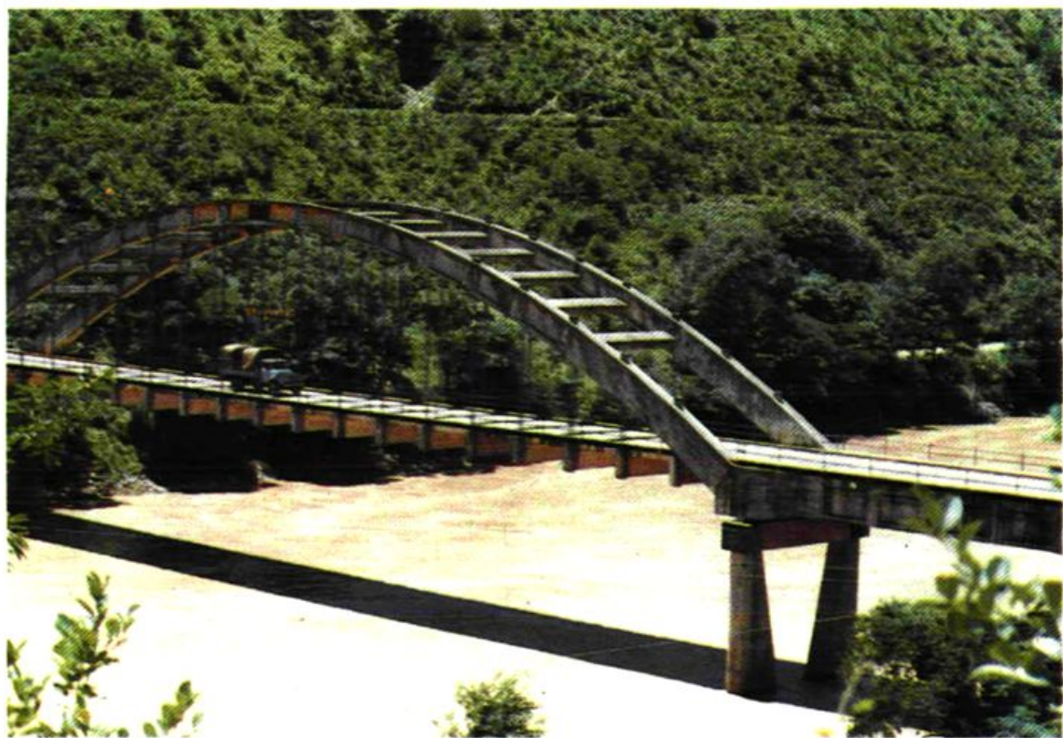
↓ 昆畹公路永保桥
