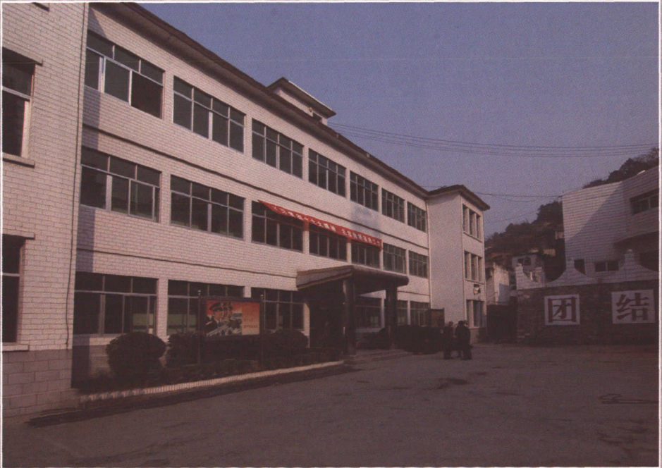
县人武部办公大楼
