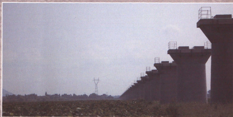
正在修建的铜九（安徽铜陵至江西九江）铁路
