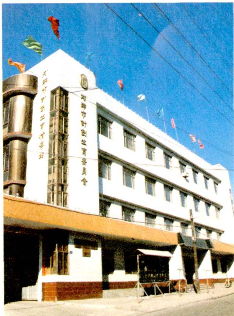
计生委办公大楼
