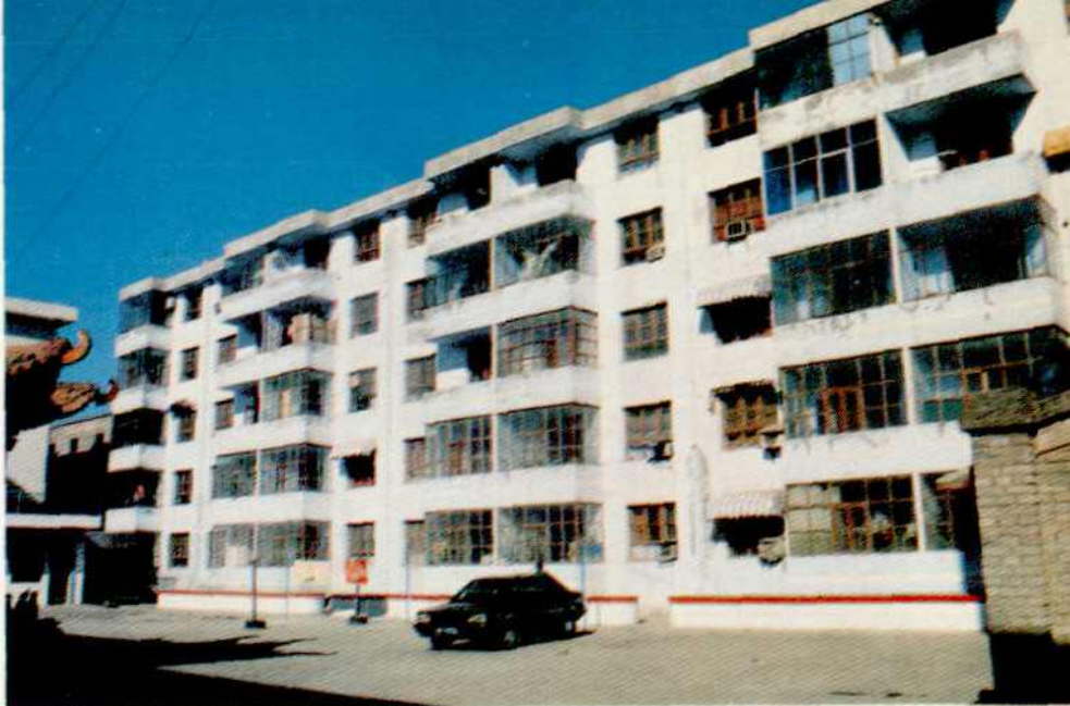
计生委职工宿舍大楼
