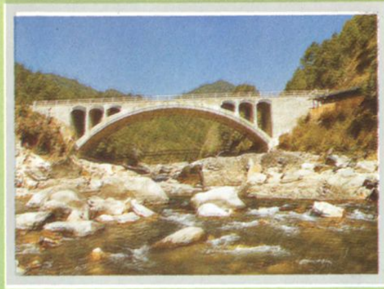
▲ 新猴桥 ▼ 东风桥 (郑祖胤 摄)
