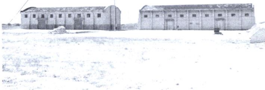
普尔塔粮站仓库
