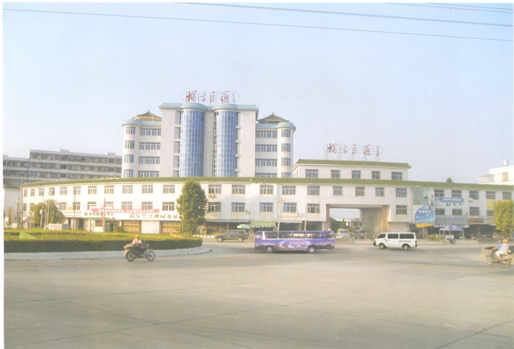
揭东县交通局办公楼及配套楼
