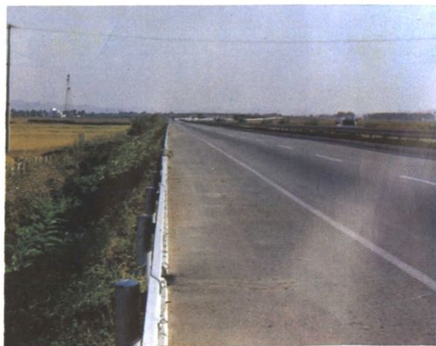
瀋大高速公路防撞板
