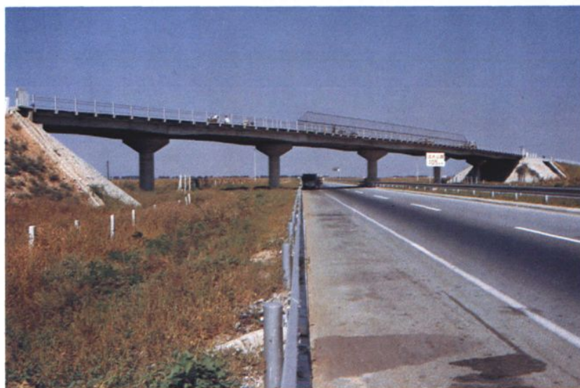
騰紫堡跨線橋
