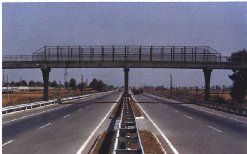
煙狼寨跨線橋
