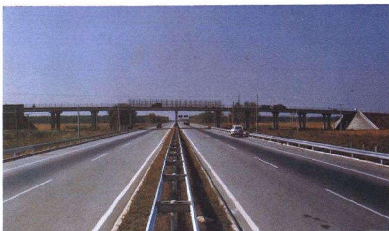
紅旗堡跨線橋
