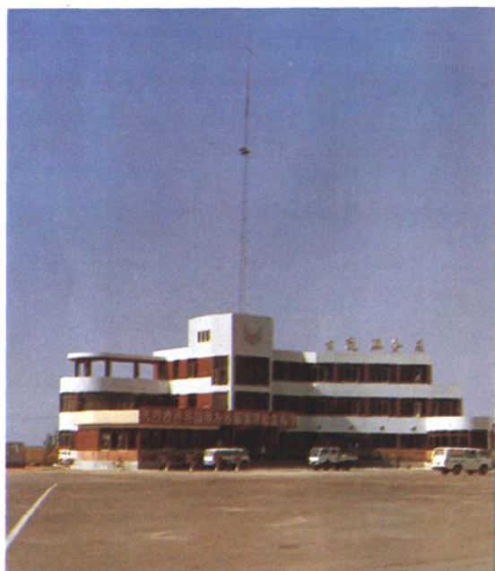
甘泉服務區二號樓
