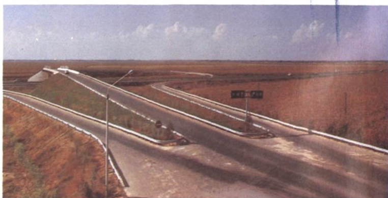
西柳互通式立交橋
