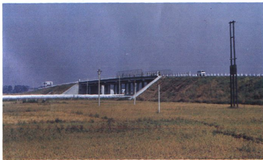
大郎台跨線橋
