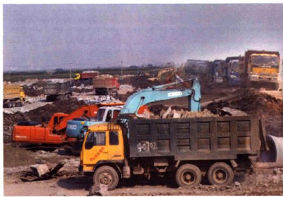
场承揽抛填工程
