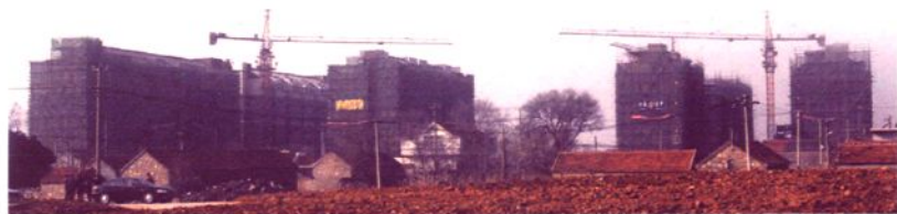
占地近200亩的三个职工小区可望近期建成，图为建设中的“裕泰新村”。
