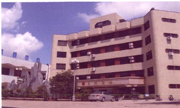
台北盐场办公大楼
