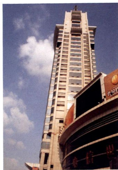
松江电信大楼
