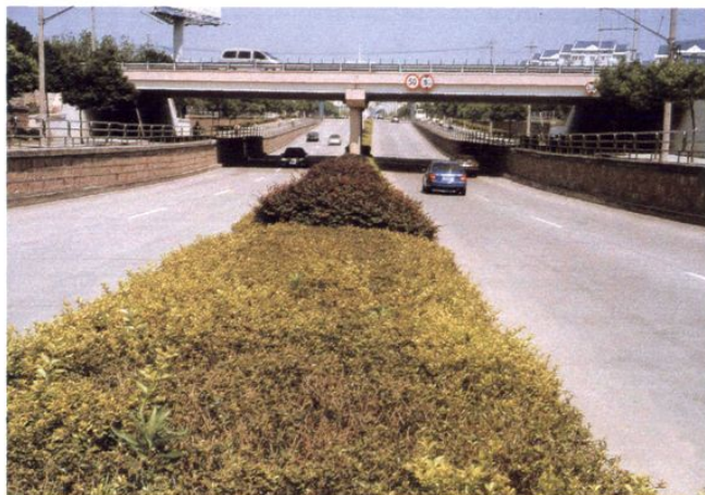
人民北路隧道
