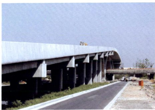
沪松公路立交桥
