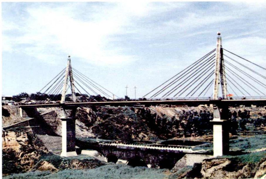
▶ 新龙桥为斜拉平桥，位于古龙桥西侧上方15米处。图为新龙桥全景。
