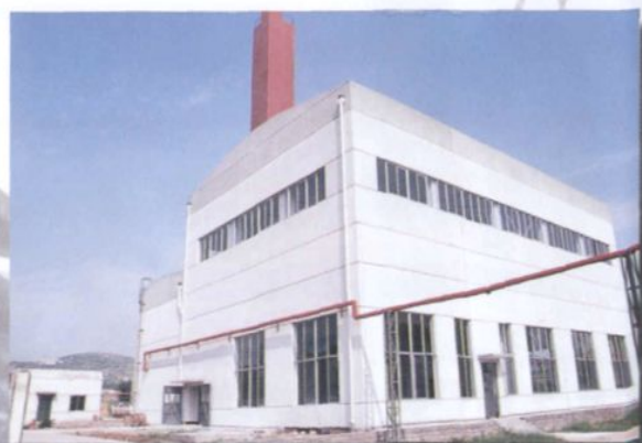
正在建设的 3200 立方米 / 时制氧机工程
