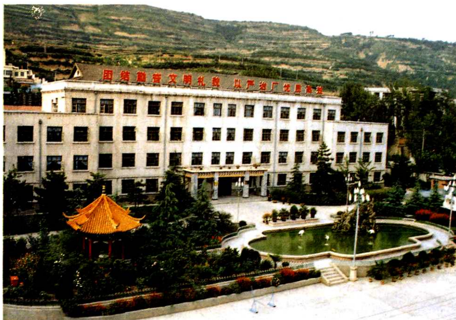
宝鸡工程机械厂办公楼
