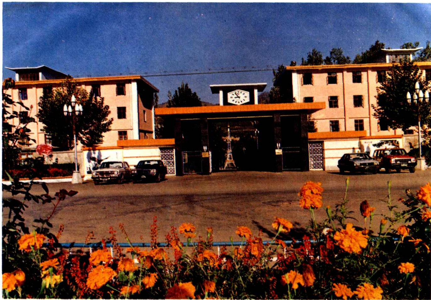
宝鸡桥梁厂大门
