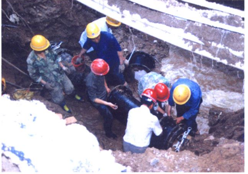
管道抢修现场
