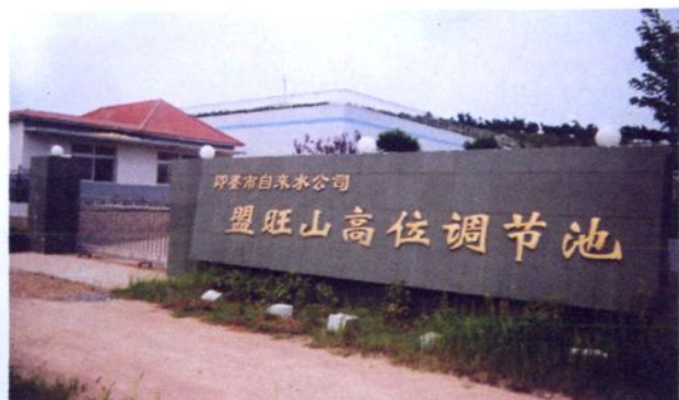
盟旺山高位调节池
