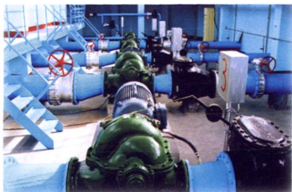
同济水厂泵房
