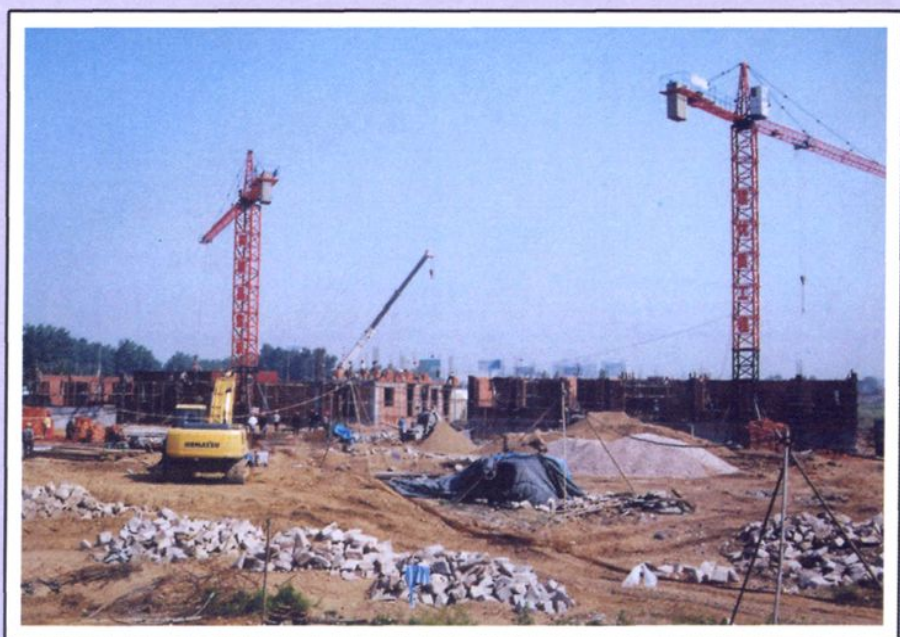
正在建设中的舞旗水厂
