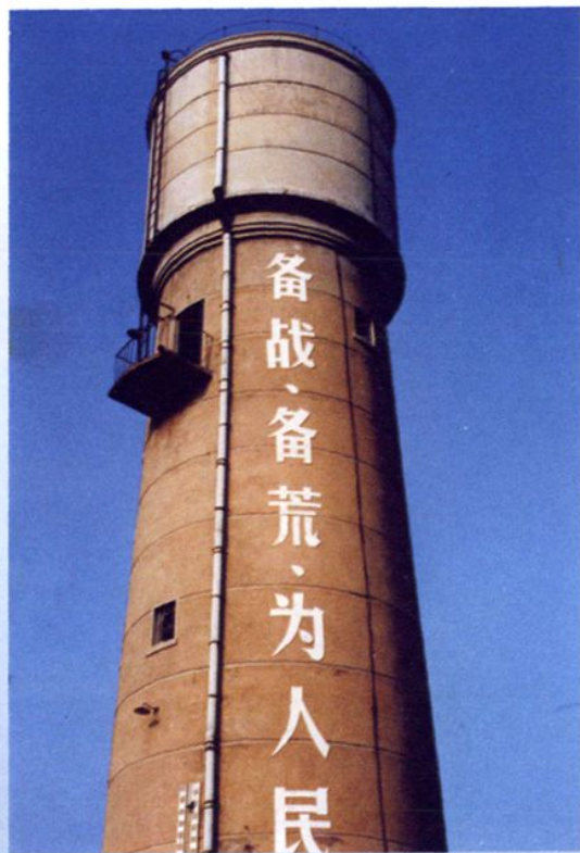
城区第一座调节构筑物——东关水塔（已拆除）
