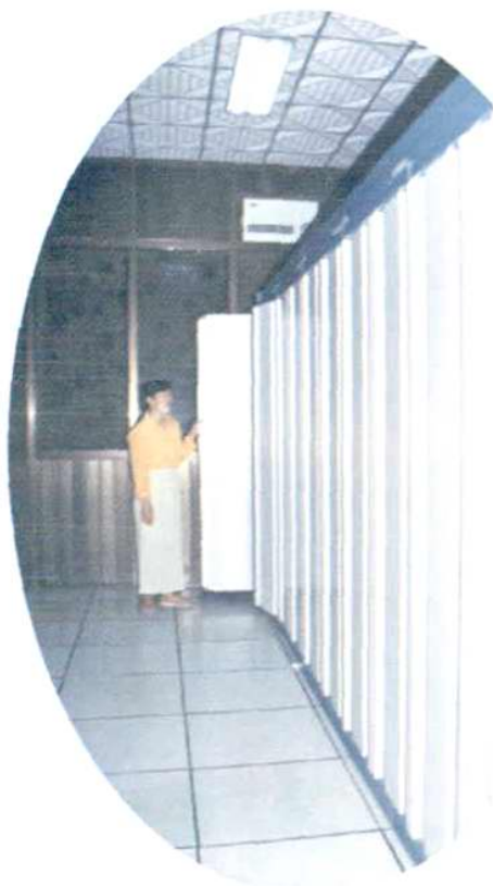
S-1240型万门程控电话交换设备
