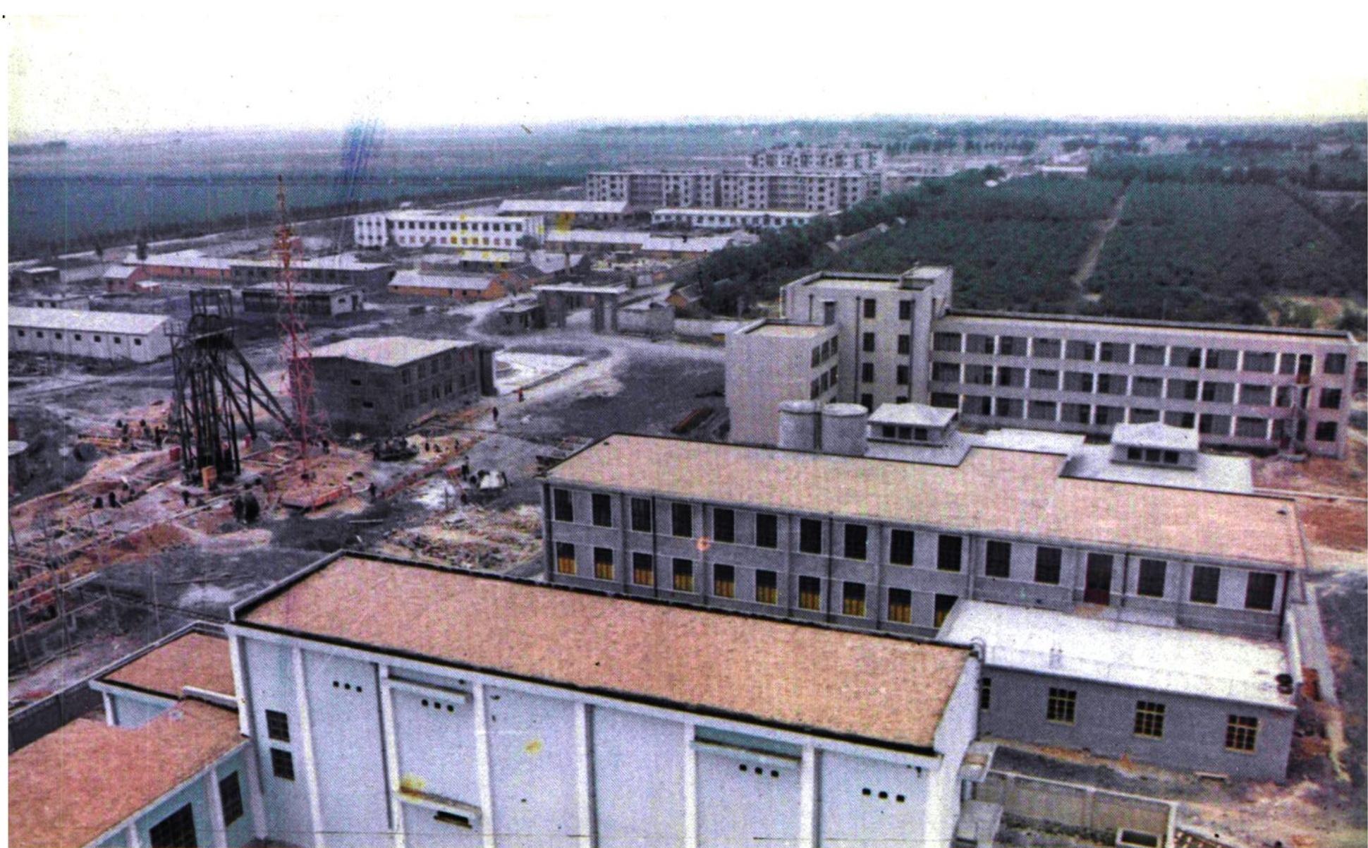
地方煤矿工业广场（泉上煤矿）
