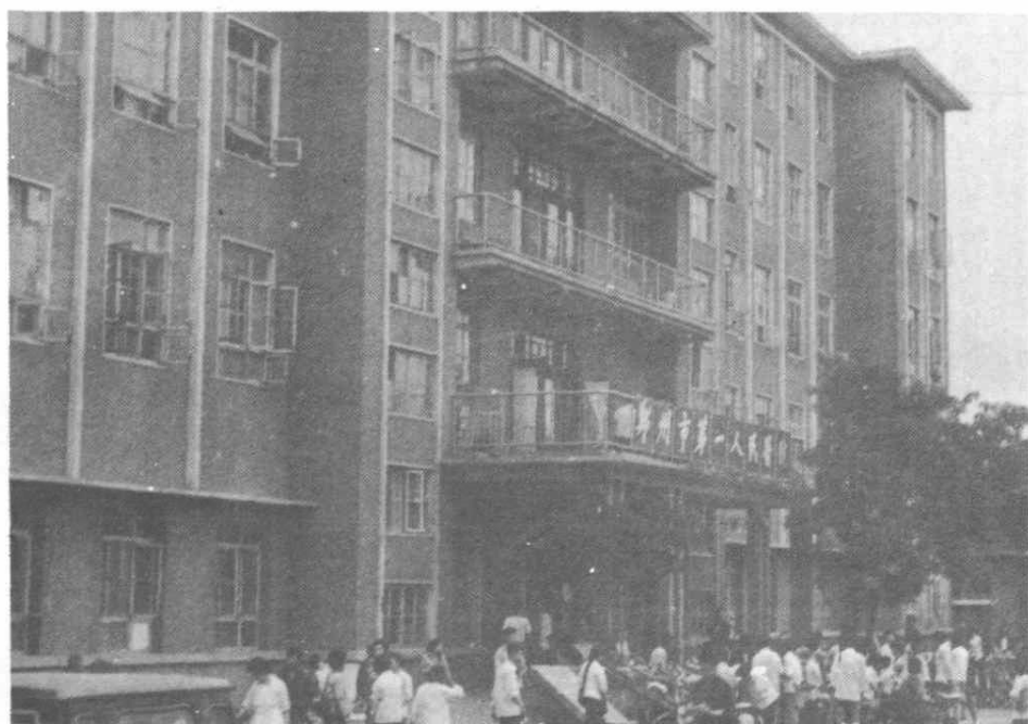
门诊大楼 (1978年建成, 建筑面积4850m 2 )
