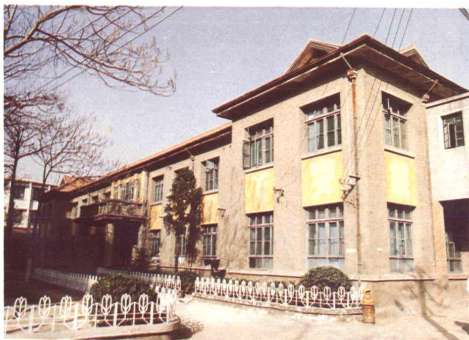
内科病房楼 (1953年建成, 建筑面积1488.5 m 2 )
