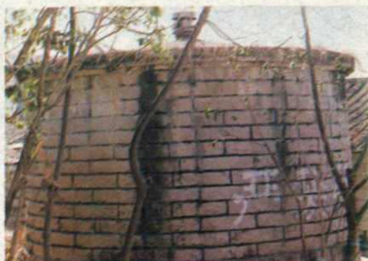
1958年建成的旧镇粮站石砌油池
