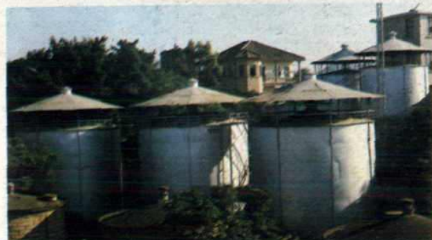
1979年建成的旧镇粮油储运站钢板油池。
