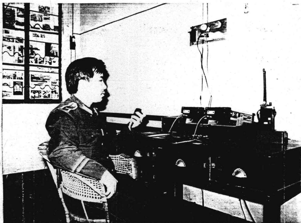
1986年9月安装的无线电集中台
