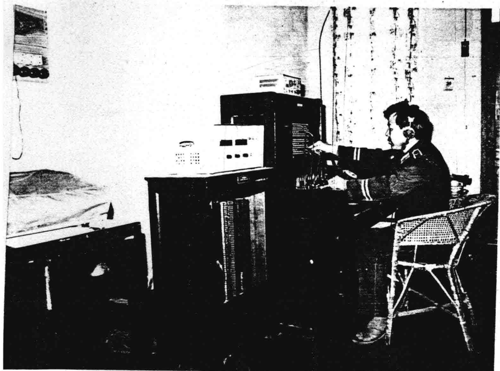
1988年元旦安装的50门共电交换机
