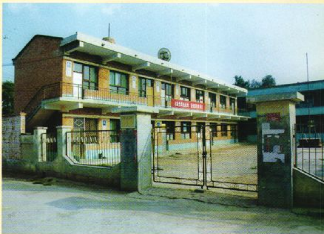
◎ 新建的小学教学楼
