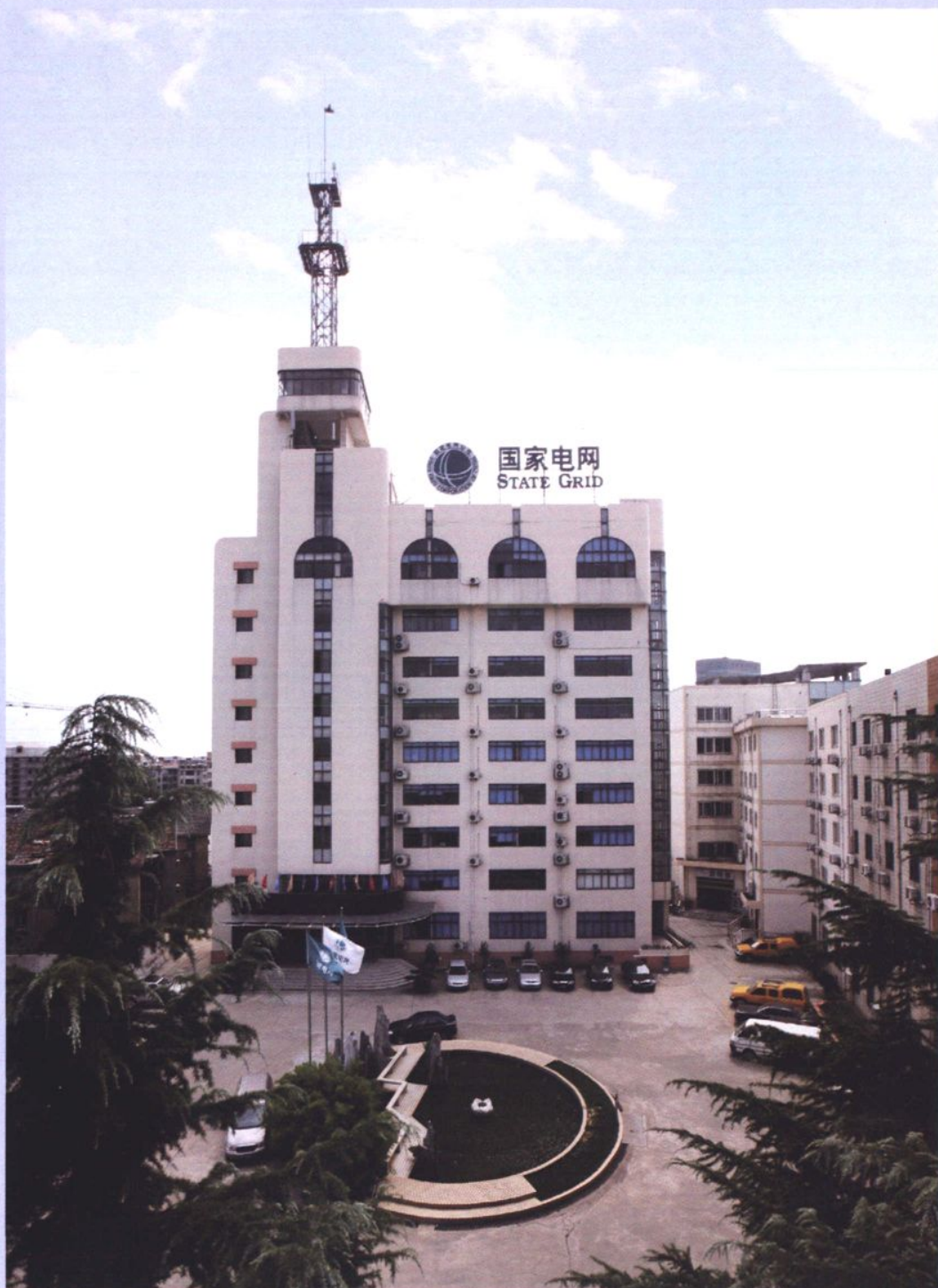
金坛市供电公司生产调度大楼(摄于2009年3月)
