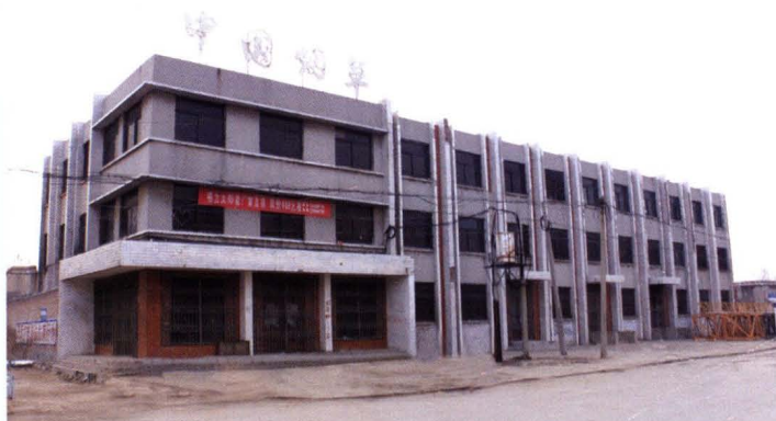
金叶小区老区办公楼
