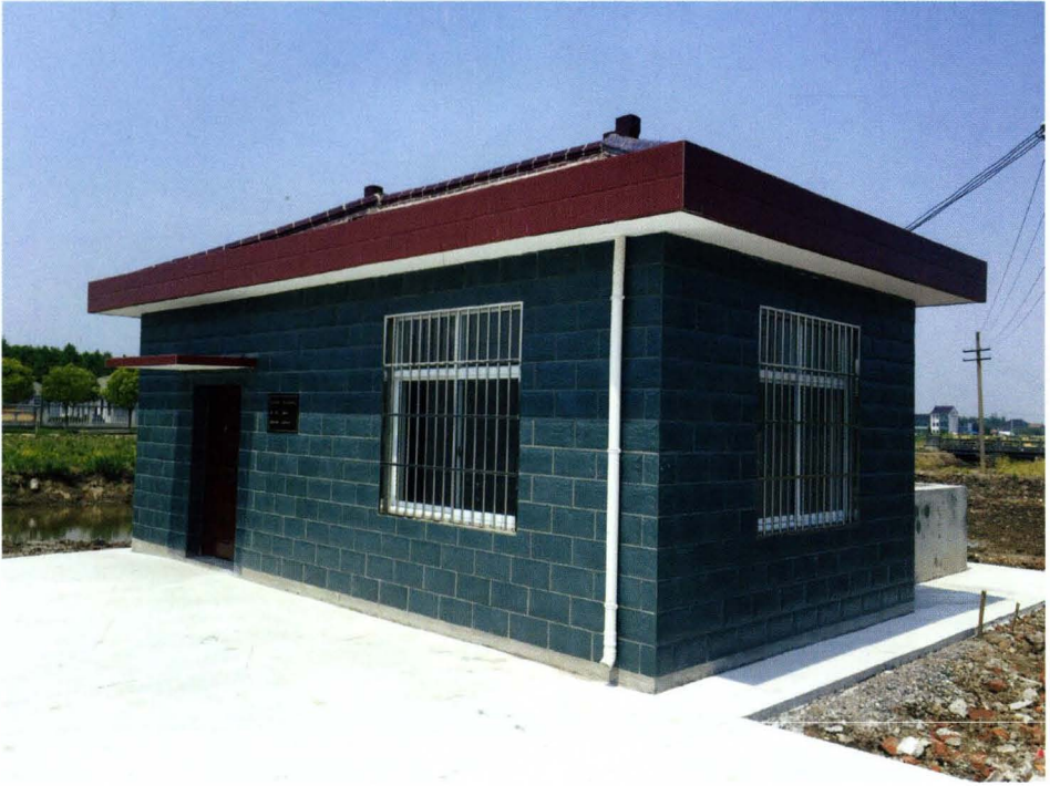
保卫村（团结）电力灌溉泵站
