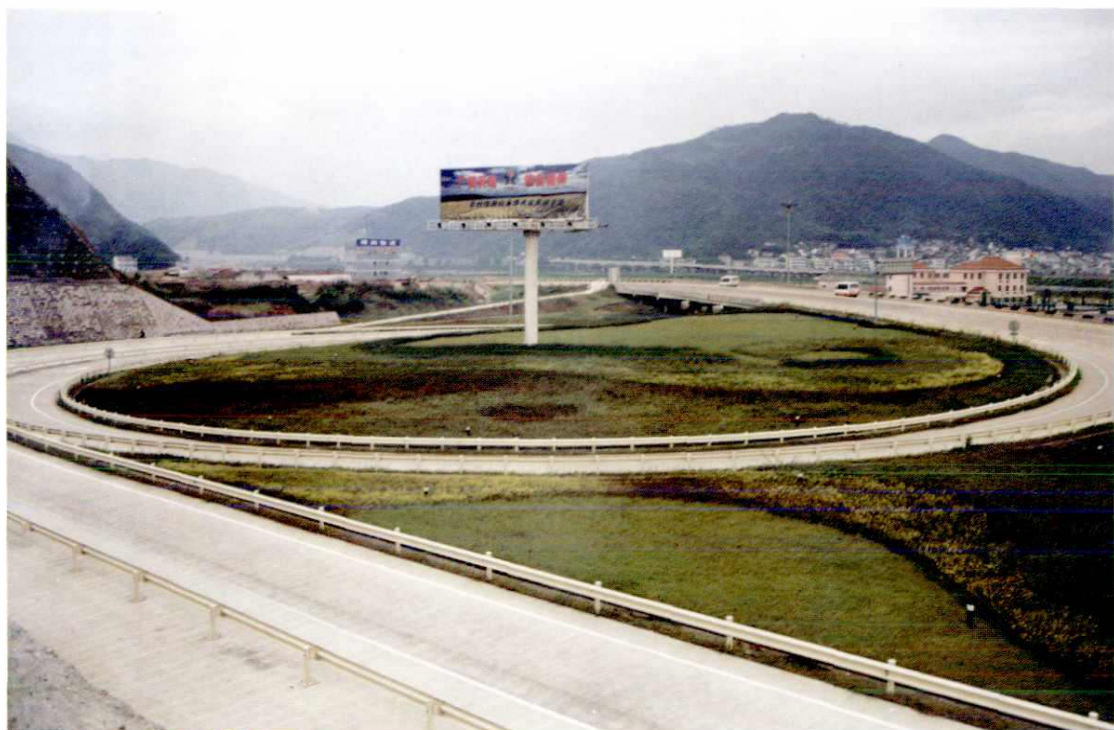
104国道禹溪互通区
