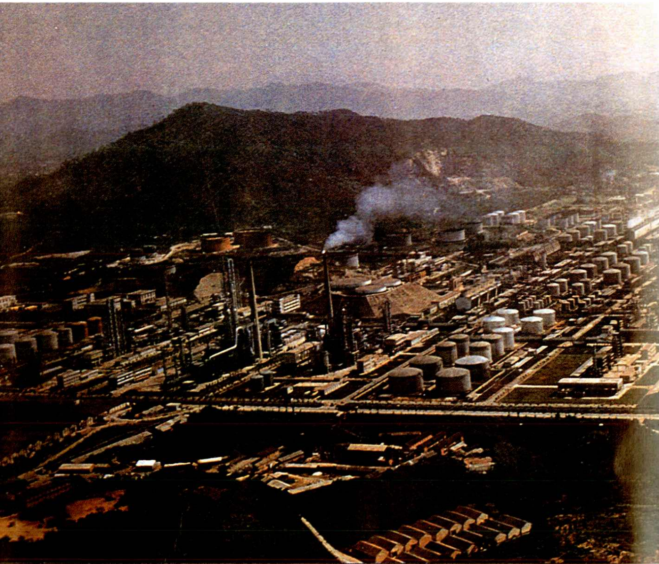
二期建设工程竣工后的厂区
