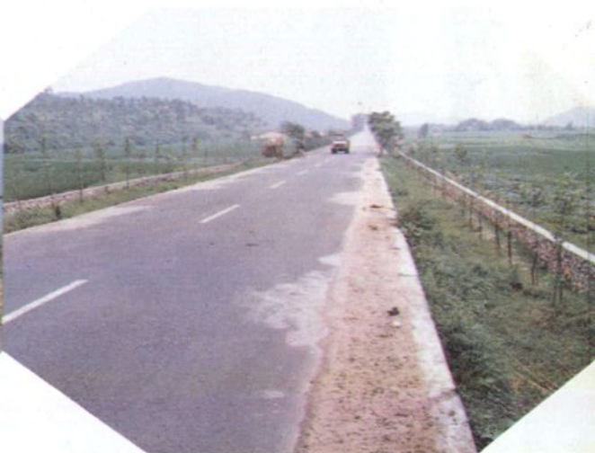
▲ 南雄、始兴、曲江等县在当地政府的重视支持下 大力进行路面加宽、营造公路绿化带。图为韶庚线长坝段。（摄于1991年）
