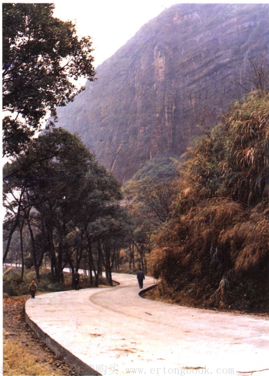
◀ 行车难成为历史。(摄于一九九一年) 坪新线坪石段铺上水泥路，韶关「北大门」
